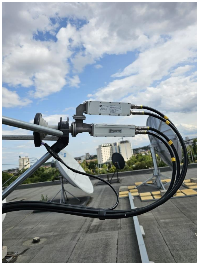
Фигура 11 – Елементи на антенната, [личен архив Красимир Терзиев]
