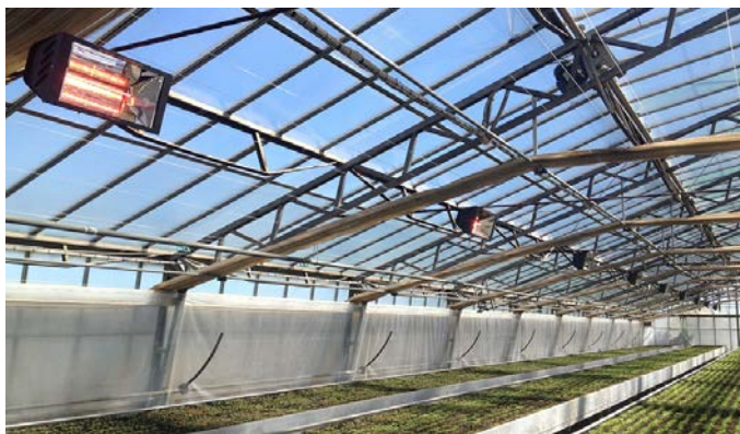
Фиг. 52: Лъчисто отопление в оранжерия
