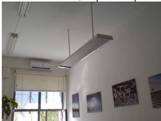
Фиг. 61: Лъчисто отопление в офис Фиг. 62: Термоснимка на работещ лъчист отоплител
