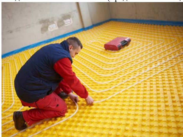
Фиг. 48: Монтаж на подово лъчисто отопление
