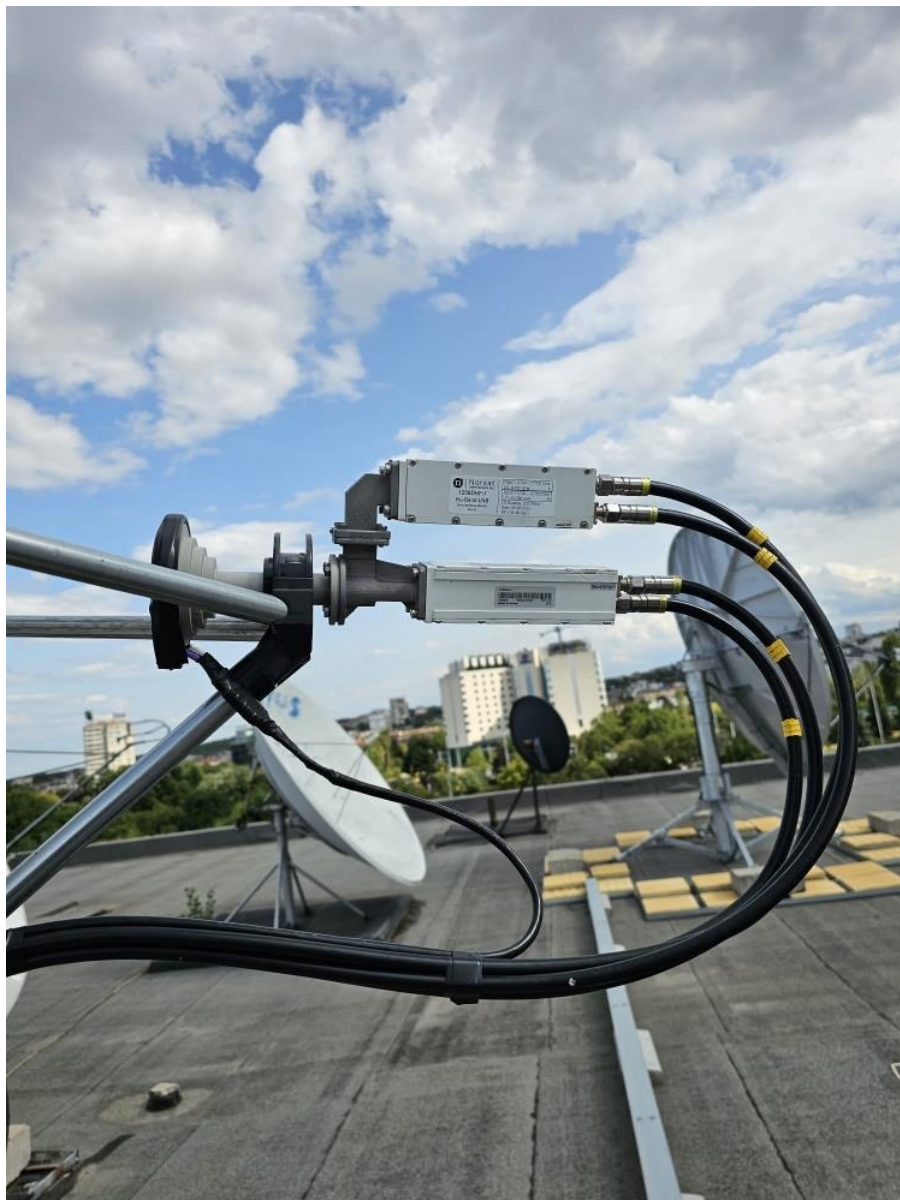
Фигура 3. Елементи на антенната, [личен архив Красимир Терзиев]
