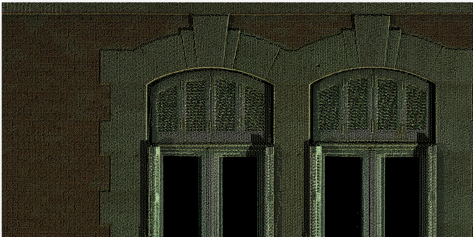
Детайл от източната фасада на Резиденция „Евксиноград“ гр. Варна
